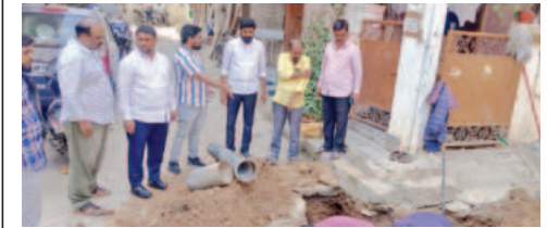
రహమత్‌నగర్‌లో మంచినిటి ఫైవలైన్ పనులలో పరిశీలిస్తున్న కార్పొరేటర్ సీఎన్ రెడ్డి.
